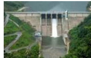
Turbine pompe à vitesse variable
