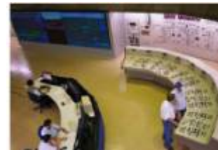
Systèmes de contrôle commande (DCS)
